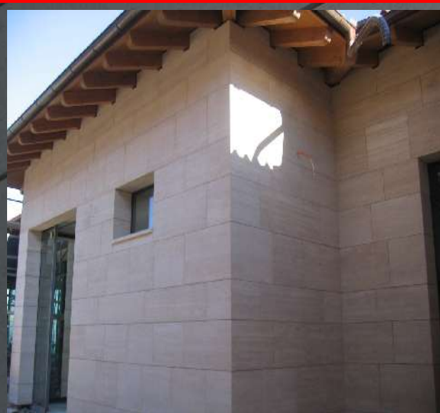
Sl.4 Pročelje vile u Samoboru
