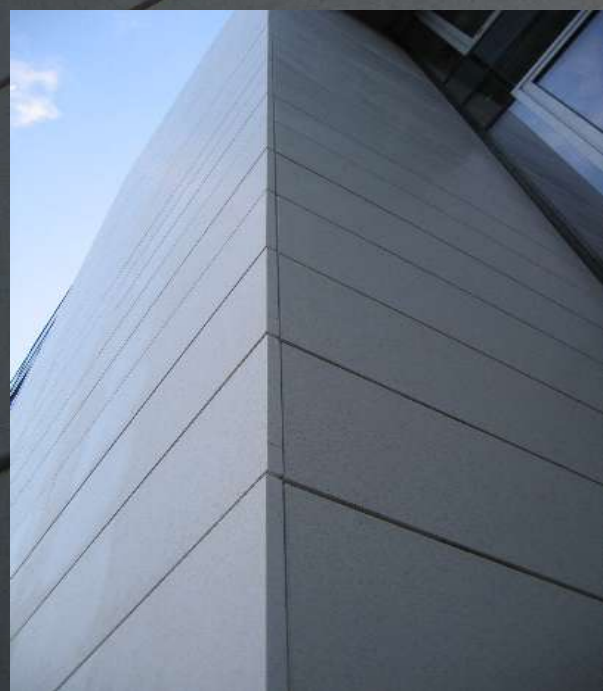
Sl.2 Detalj ugla zgrade sa umjetnim kamenom QUARELLA
