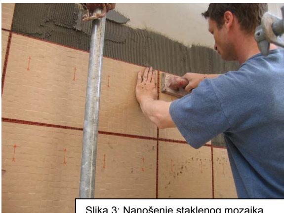
Slika 3: Nanošenje staklenog mozaika
